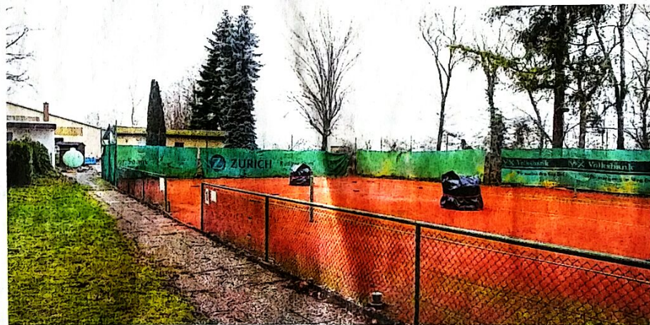
Das besagte Grundstück. Im Hintergrund ist die alte Hütte zu erkennen, die abgerissen werden und durch einen Neubau ersetzt werden soll. Um den Sandplatz zieht sich ein Zaun, der marode ist und der Gemeinde gehört, halten Saam und Hampel fest.
